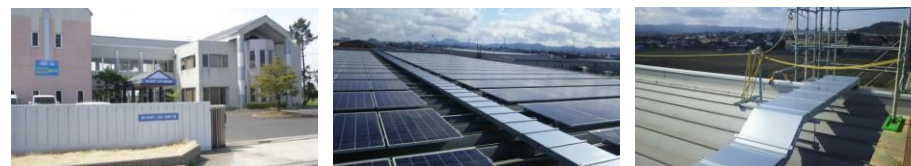
ユニットコム出雲工場屋根部分 → 電力使用料の削減を図る
